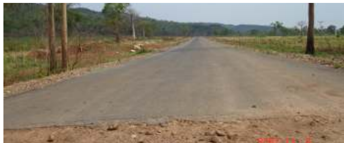
Final da parte pavimentada próximo a Nova Roma
