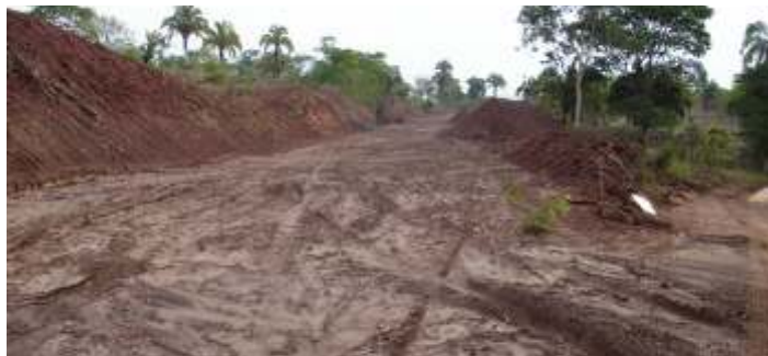
Serviços de terraplenagem paralisados
